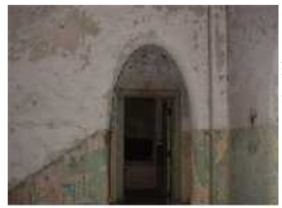
2階応接室前にもアーチ
