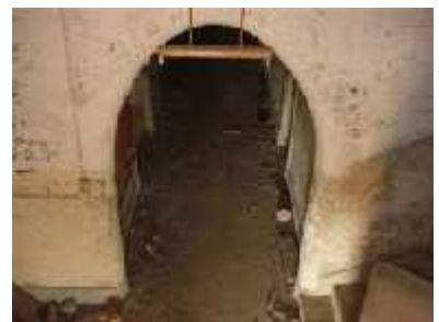
1階部分のパラボラアーチ
